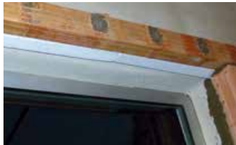
Sturz mit Ziegel-Flachsturz (hochkant) und rückseitiger Wärmedämmung oder Wärmedämmputz.
