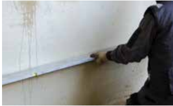
Untergrund prüfen auf Ebenheit, lose Putzstellen usw.
