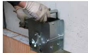
Mörtel mit Mörtelschlitzen auftragen.
