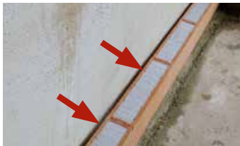
Planfuge \geq 2,0 cm zwischen WDF und Bestandswand.
