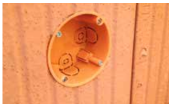
Elektroinstallation mit Leerrohren und Hohlraum Dosen.
