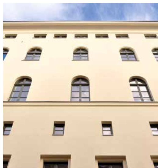
Die sanierte Fassade an der Klosterstraße 5.
