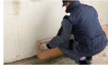
Erste Steinlage anlegen.
