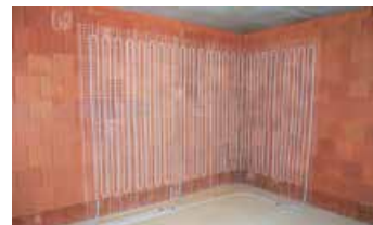
Poroton-WDF bietet einen optimalen Untergrund zur Montage von Wandheizsystemen.
