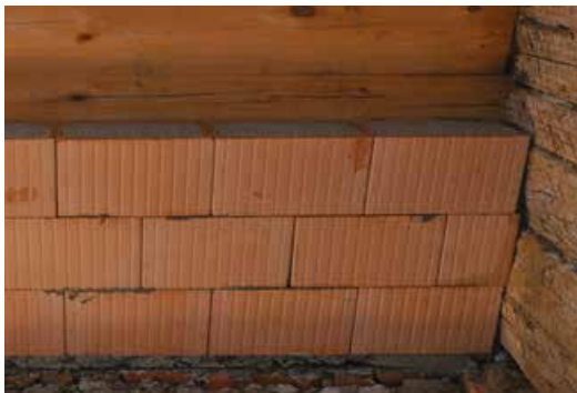
Beispiel für eine Innendämmung eines alten Bauernhauses in Holzblockbauweise mit Poroton-WDF. Die Außenwand kann im Original erhalten werden.
