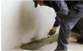
Höhenausgleich mit Anlege- u. Hinterfüllmörtel auf der Bodenplatte oder der Geschossdecke.
