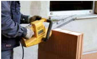
Passsteine mit geeignetem Werkzeug schneiden (WDF-Ausgleichsziegel verwenden).
