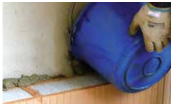
Mit Anlege- und Hinterfüllmörtel* hohlraumfrei hinterfüllen.
