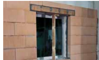
Fertigstellung der Innendämmung.
