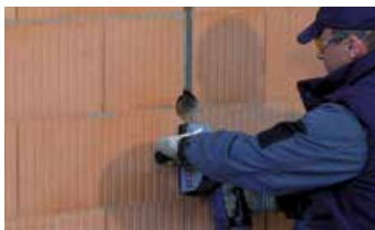
Installationsschlitze werden mit einer Mauernutfräse erstellt.
